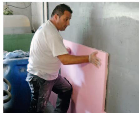
Nach den Rissinjektionen mit Mapejet Easy 150 wird die Wand im Generatorraum mit Mapetherm AR1 Light und Mapejet 150 isoliert
