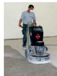
**Kugelstrahlen, Demarkierung, Aufrauen, Schleifen, Zementhaut entfernen.**
