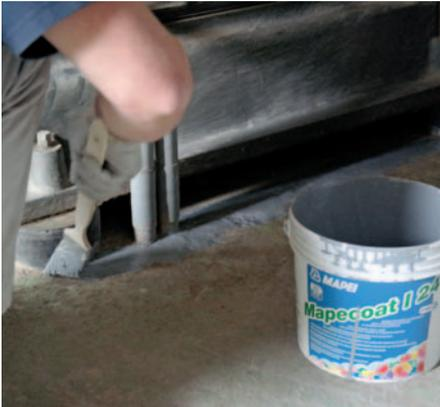
Der Mapecoat I 24 Epoxidharzanstrich schützt Betonflächen vor chemischen und mechanischen Belastungen – Generatorraum
