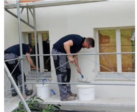
Die Aussenfassaden wurden mit Elastocolor Pittura behandelt, einem Schutzanstrich auf Acryldispersionsbasis für den Innen- und Aussenbereich.
