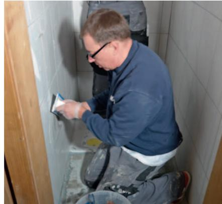
Verfugung der Sanitäranlagen im Erdgeschoss mit Ultracolor Plus, die Flexfuge mit DropEffect® und BioBlock®-Technologie.
