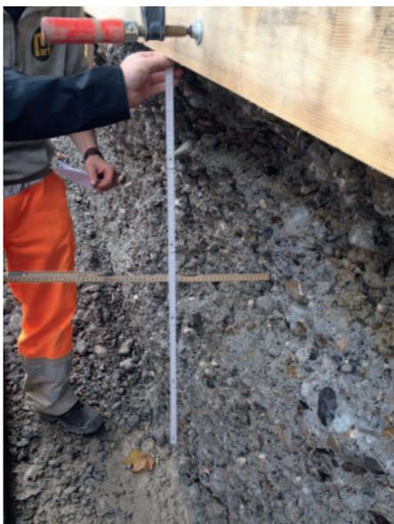
Nach dem Betonabtrag ist der Untergrund mit und die Betonqualität erkennbar. Die Auftragsstärke ist anhand der Doppelmeter erkennbar.
