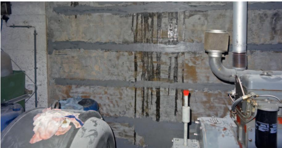
Undichte Wand (Bergseite) im Generatorraum vor der Sanierungsarbeiten.
